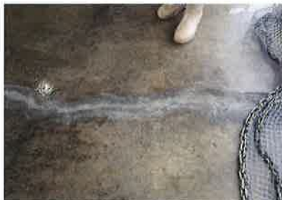
床の溜み修繕跡
