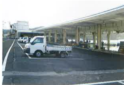
荷捌き施設外観（陸側）
